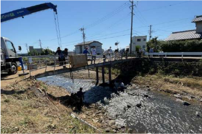
庵原川② 原 水色橋 （伊佐布工区の洗堀用石倉カゴが下流の水色橋まで流出）
