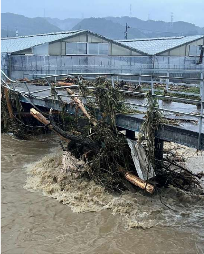
庵原川② 原 水色橋 （伊佐布工区の洗堀用石倉カゴが下流の水色橋まで流出）
