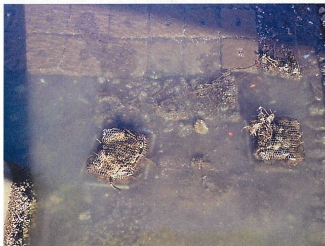
既設石倉カゴ現状確認
