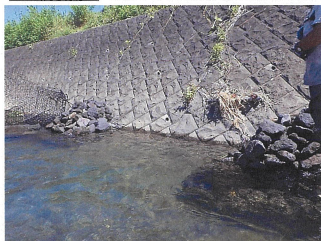
モニタリング石倉カゴ引揚げ完了
