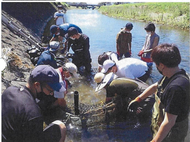
中詰材取出し
