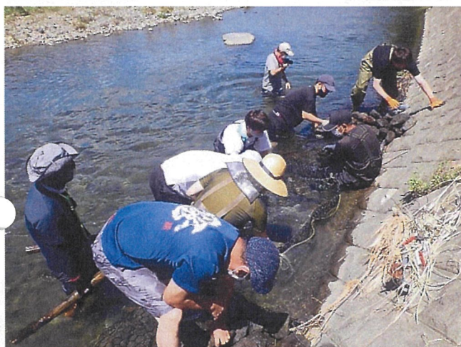
石倉カゴ再設置～中詰石投入
