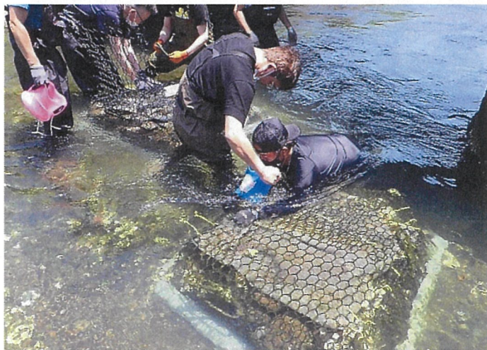
石倉カゴ再設置 蓋閉め
