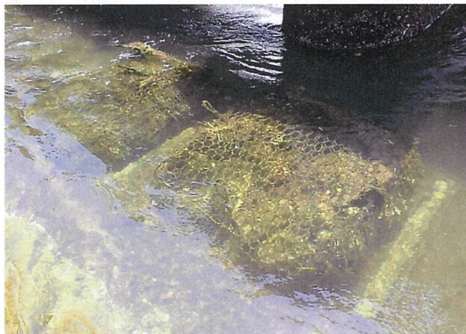
既設石倉カゴ現状確認
