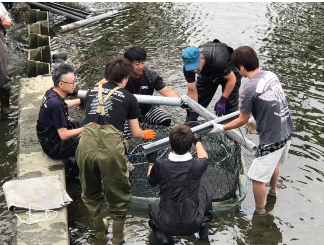
入れ替え石倉カゴ組立て
