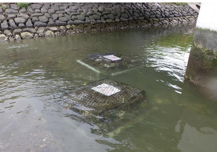
石倉カゴ再設置
