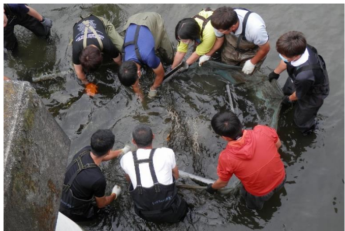
石倉カゴ中詰め材入れ替え～再設置
