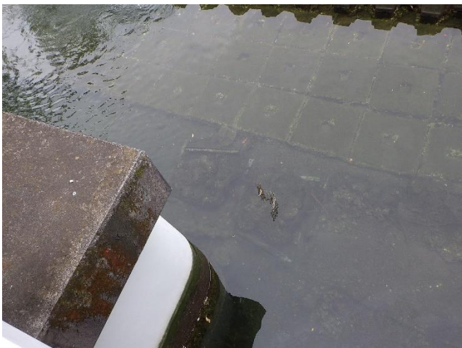
既設石倉カゴ現状確認
