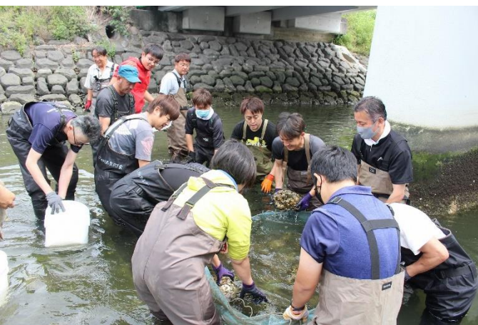
石倉カゴ中詰め材入れ替え～再設置
