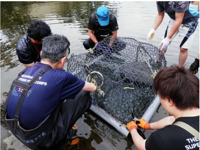
入れ替え石倉カゴ組立て
