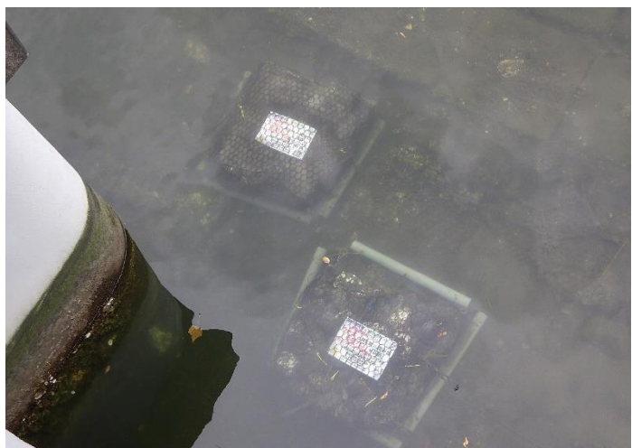
石倉カゴ再設置
