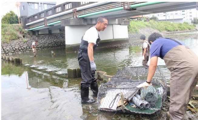
入れ替え石倉カゴ準備
