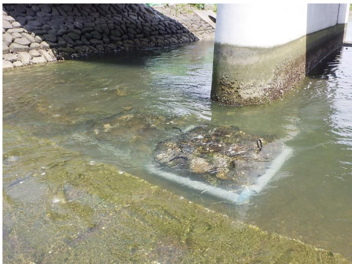
石倉カゴ再設置完了
