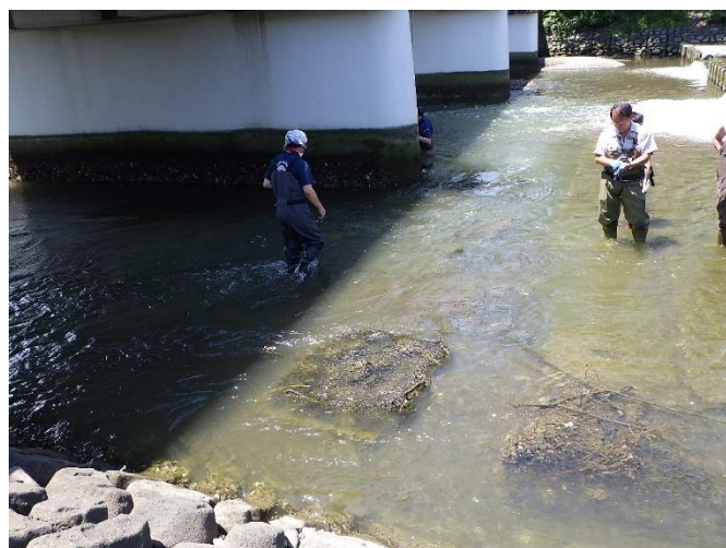
石倉カゴ設置場所確認
