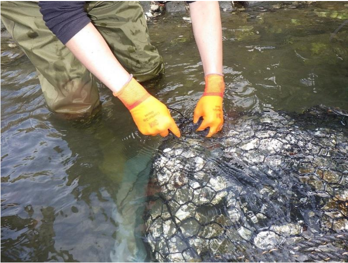
石倉カゴ④ 蓋閉め
