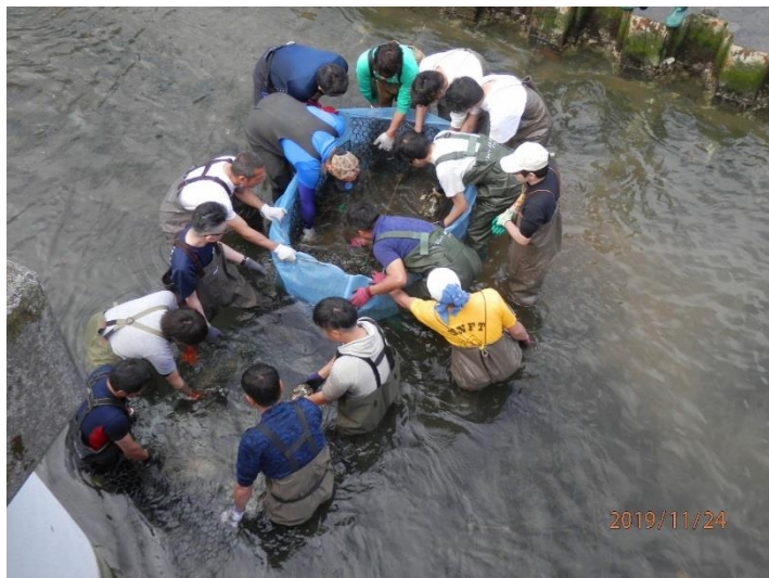
石倉カゴ③中詰め石の入替え
