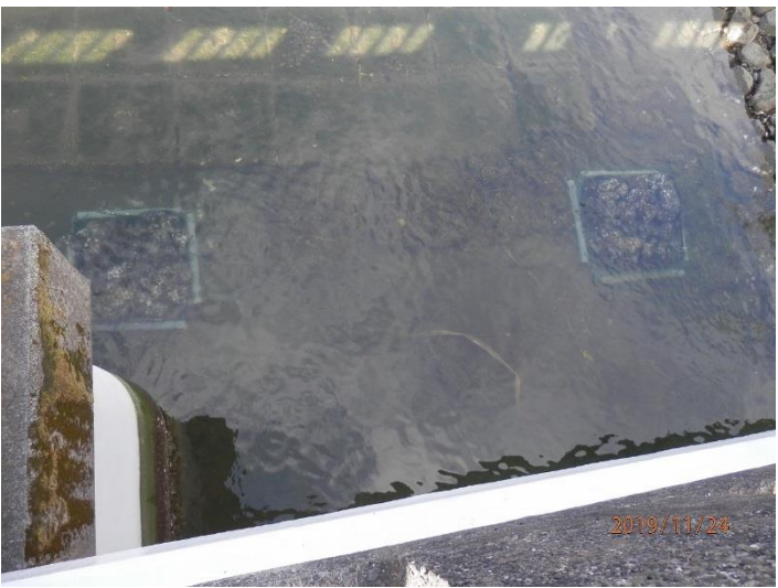
石倉カゴ③、④ 再設置 完了
